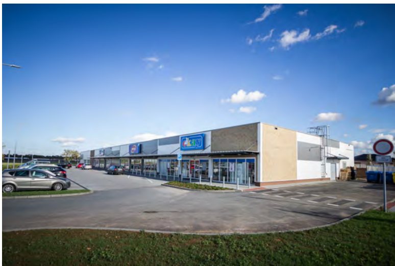
SWIETELSKY stavební s.r.o.
