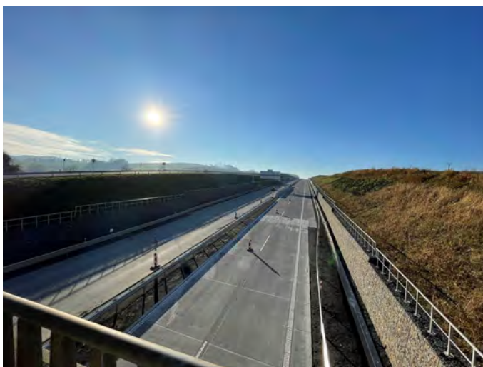
SWIETELSKY stavební s.r.o.
