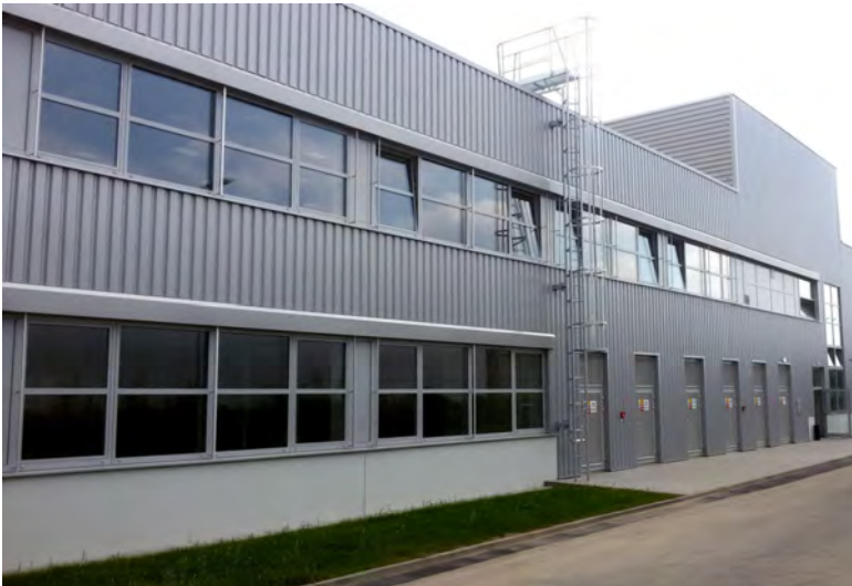
SWIETELSKY stavební s.r.o.
