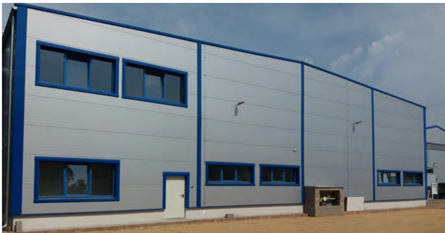
SWIETELSKY stavební s.r.o.
