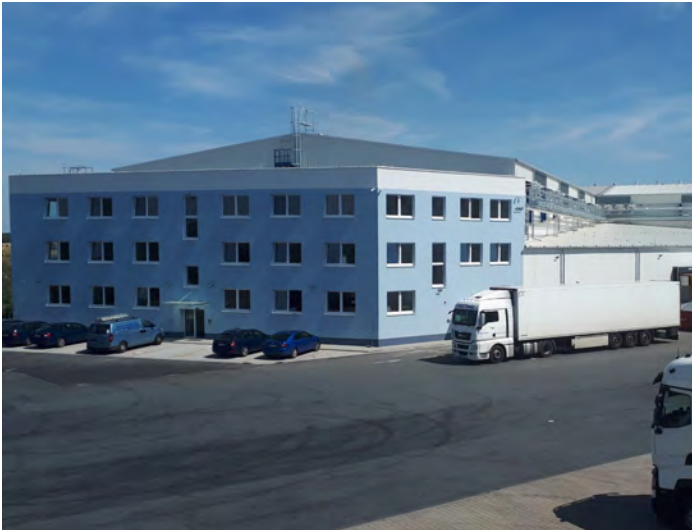
SWIETELSKY stavební s.r.o.
